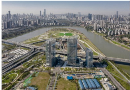
项目采用了多种装配式建筑形式,整体装配率约80%。
