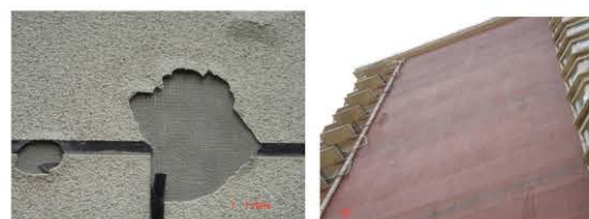
干挂岩棉的实际效果相对较差 龙骨安装复杂存在冷热桥
