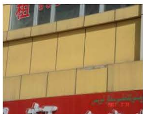
阳角部位：板缝开裂、渗水，饰面板遇水起皮、开裂。
