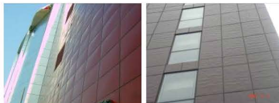
金属复合保温装饰一体化系统起鼓变形 （以前的方式0.5-0.8mm厚的金属铝板）
