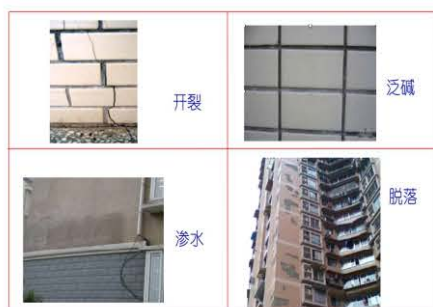
外墙渗水、开裂、泛碱、渗水、脱落
