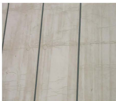
外墙渗水、开裂、泛碱、渗水、脱落
