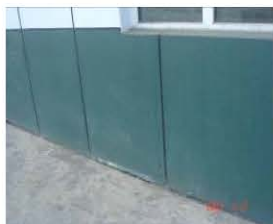
低层没有做好防水处理，装饰板遇水膨胀起翘。
