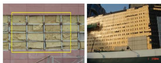
干挂岩棉的实际效果相对较差 龙骨安装复杂存在冷热桥
